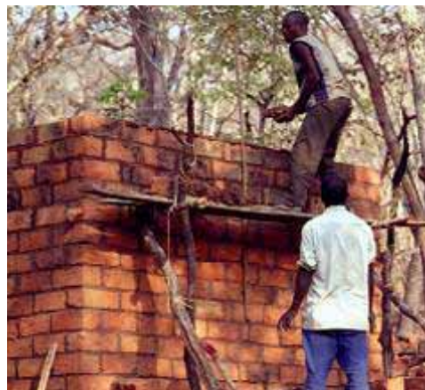
レンガを積み上げる様子
